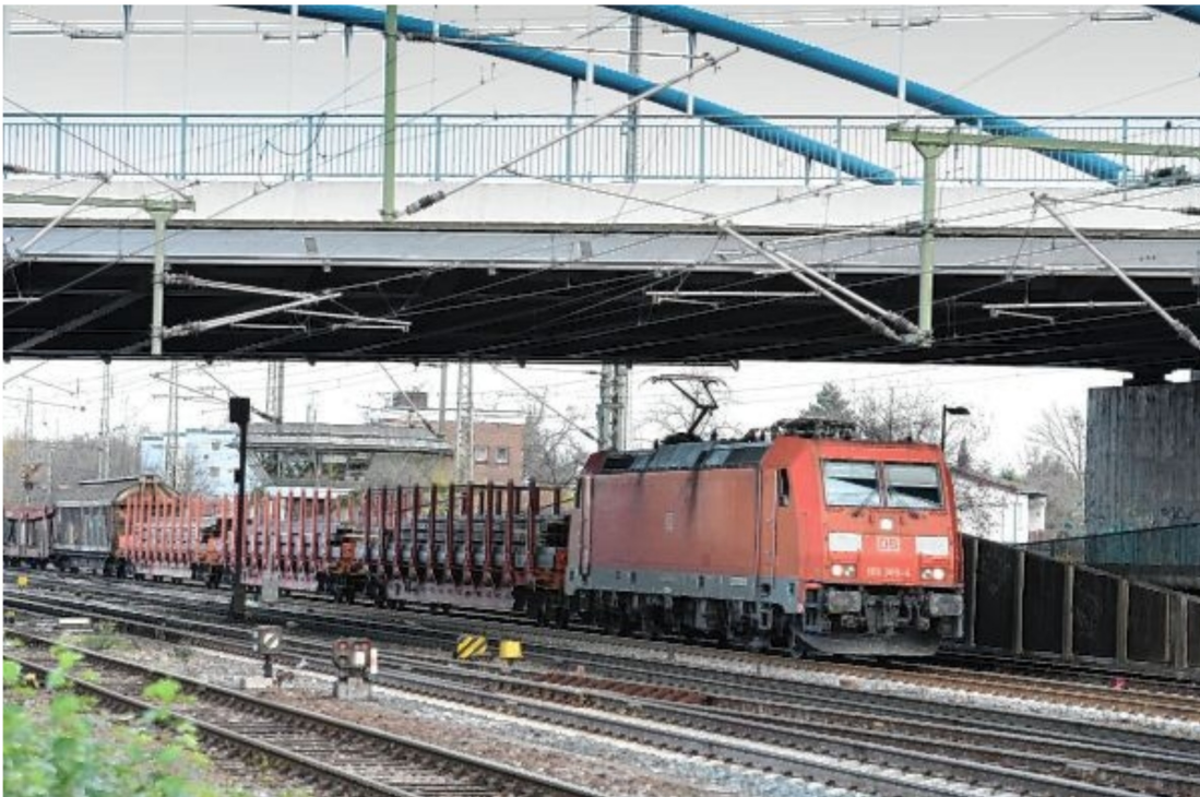
Die Riedbahnstrecke unter der Walter-Pahl-Brücke im Bereich Gartenstadt/Waldhof: Hier würden nach bisherigen Planungen auch die Züge von der Neubaustrecke in die Stadt einfahren. (Bild: Rittelmann)
