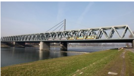
Eisenbahnbrücke (Quelle: Fotolia / Klaus Eppele)
